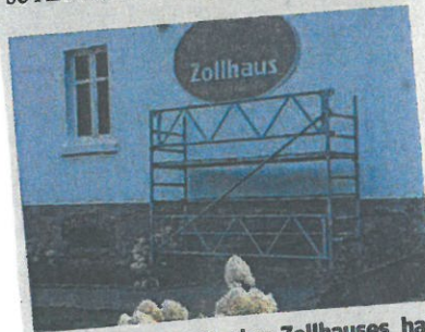
Die Außenfassade des Zollhauses hat ein neues Logo.
