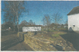
Wurde restauriert: Bruchsteinmauer am Zollhaus. FOTO: WABE
